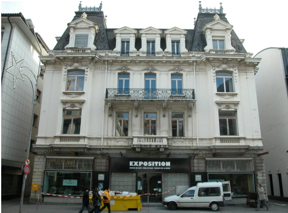
Le bâtiment de la Fondation B.+S. Tissières avant les travaux de restauration (2002-2003). Photo M. Voillat
