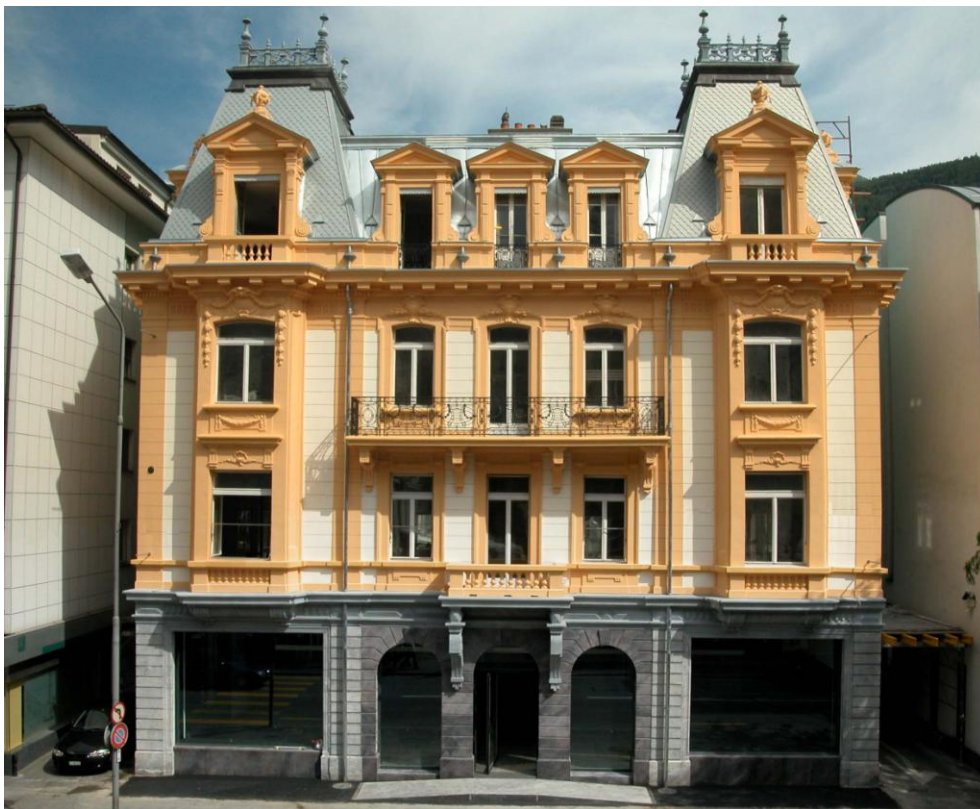
Le bâtiment de la Fondation B.+S. Tissières après les travaux de restauration (2002-2003). Photo M. Voillat
